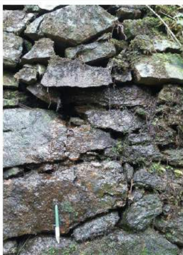
Figure 2-9 : Ecoulements à travers le parement
