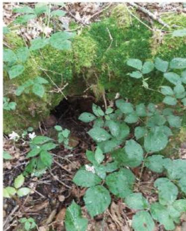
Figure 2-20 : Ouvrage identifié en rive droite
