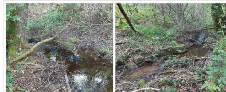
Figure 2-16 : Surverse en rive droite depuis la retenue en amont
