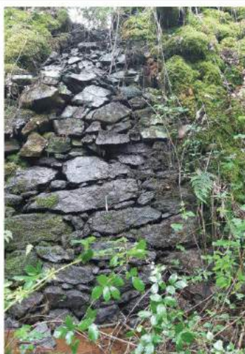
Figure 2-8 : Déversoir et zone d'écoulement
