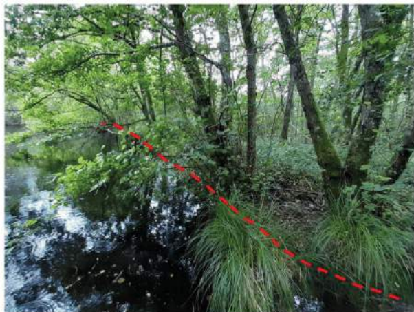
Figure 2-23 : parement amont non visible et très végétalisé
