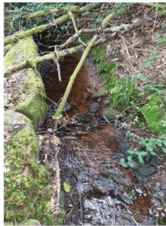
Figure 2-18 : Canal en pierres
