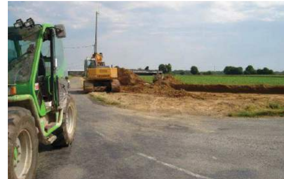
Photo 144 : Les travaux de rectification d'un virage
